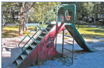
до после Ул. Кржижановского, д. 15, 17/2
