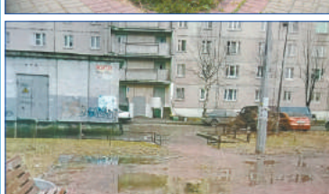
ДО ПОСЛЕ Ул. Коллонтай, д. 14/4
